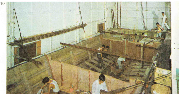
1-2. 工作間。 3. 髹漆。 4. 油船底。 5. 燒焊。 6-7. 自動車床。 8. 修理船機活塞。 9. 裝修中之「海上的士」。 10-11. 在特備廠房倒模造成之「海上的士」船身。
